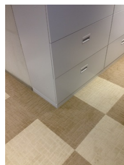
社内床 カーペット施工
